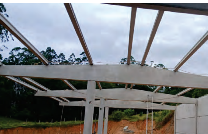
Obra realizada na Associação Desportiva e Cultural Taquaras.
