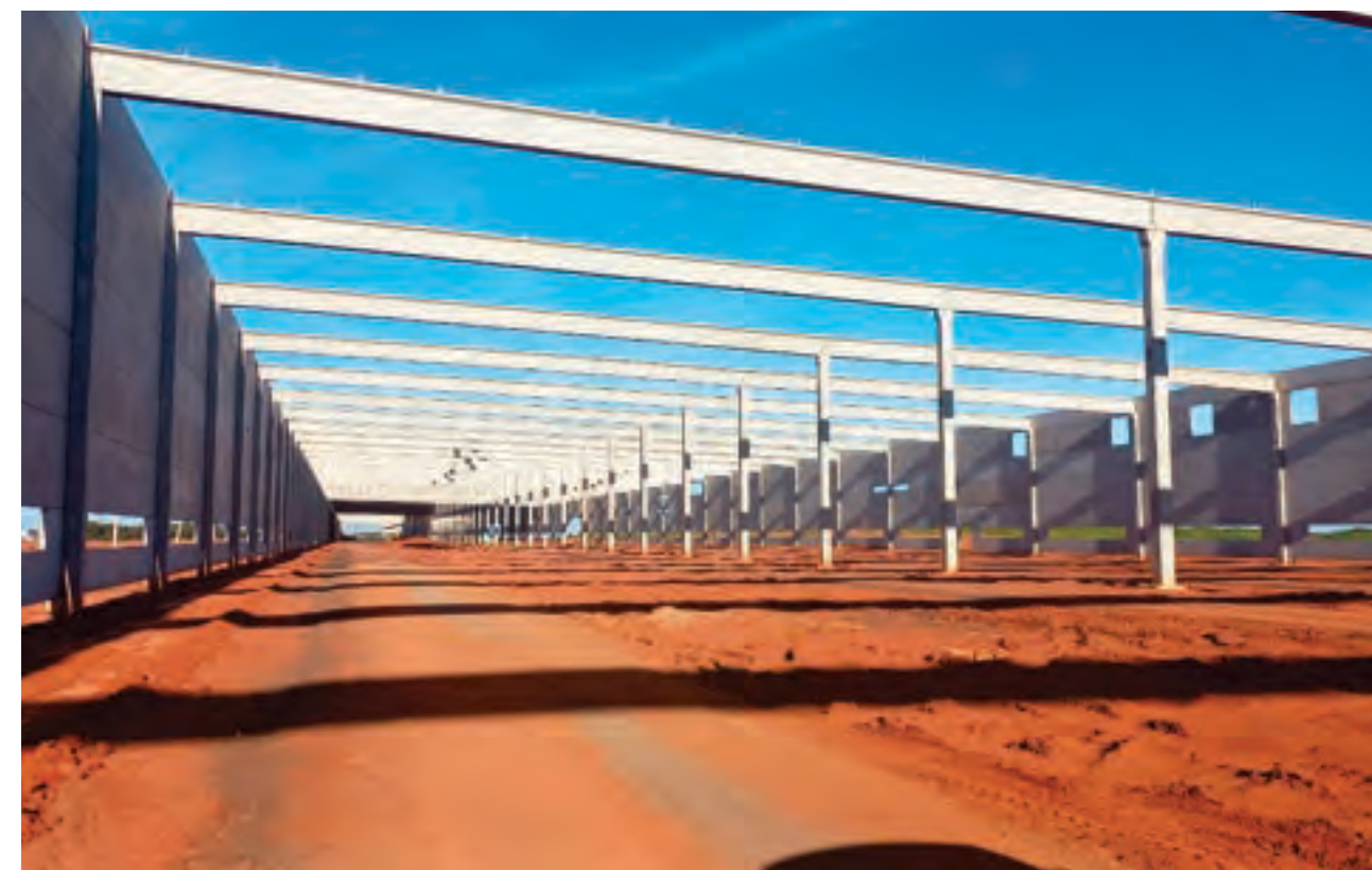
Registro da etapa do empreendimento da nova fábrica da Dexco em Botucatu/SP, iniciada em 2022. A imagem exemplifica a questão de limpeza no canteiro de obras, onde não ficam resíduos durante a montagem do pré-fabricado.
