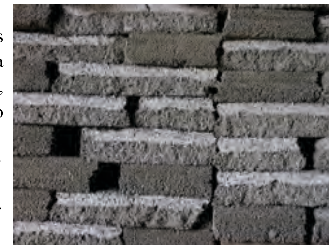
Blocos de EPS incorporado com concreto, para utilização nas lajes.
