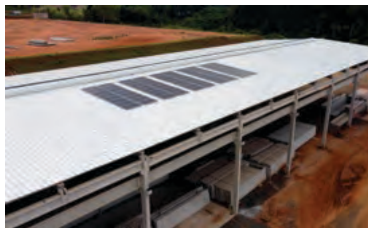
Foto da cobertura da unidade de Agudos, mostrando as placas solares e lanternim instalados para melhor eficiência energética.
